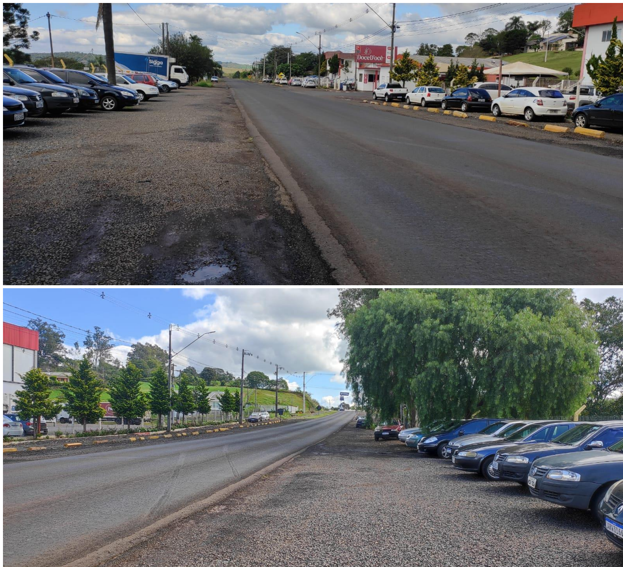
Figura 3 - Fotos ao longo do trecho.
