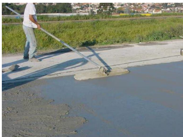
Figura 5 - Ilustração do uso de desempenadeira float.
