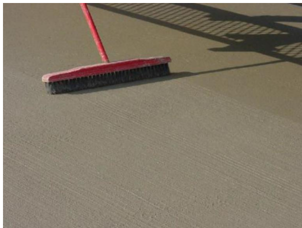
Figura 6 - Exemplo de execução de textura com vassoura.
