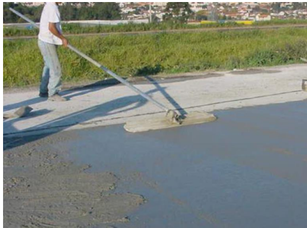
Figura 5 - Ilustração do uso de desempenadeira float.
