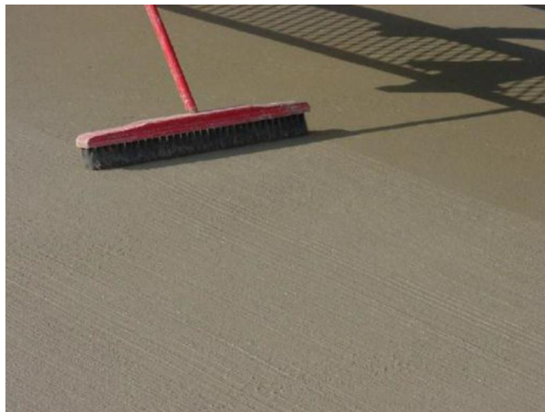
Figura 6 - Exemplo de execução de textura com vassoura.
