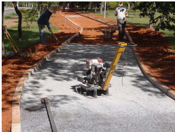
Figura 3 - Ilustração de sub-base granular sendo compactada com placa vibratória.
