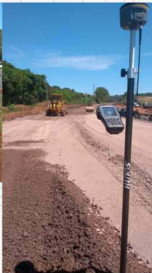
Locação Topográfica e acompanhamento de Obra de uma ponte sobre o Rio Andrada, situada em Boa Vista da Aparecida.
