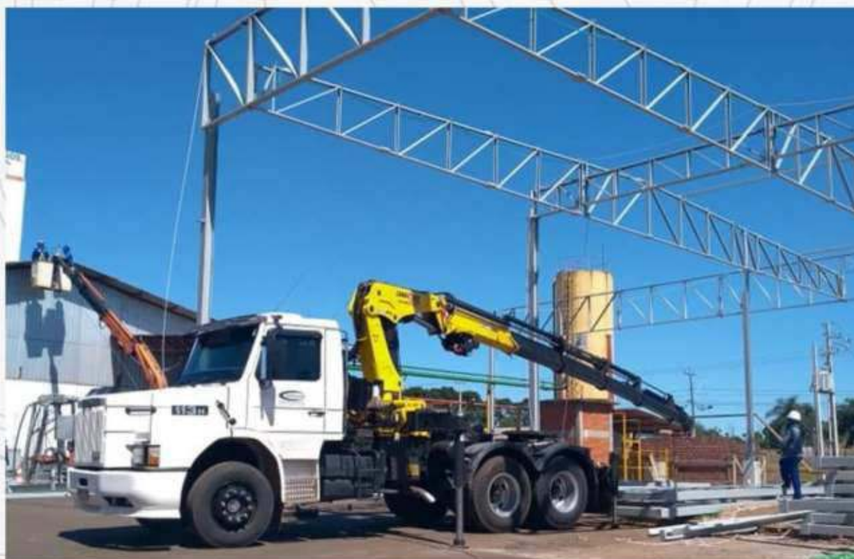
Demarcação e acompanhamento de Estrutura Metálica realizado no Frigorífico e Abatedouro de Aves da empresa Dip Frangos s/a.
