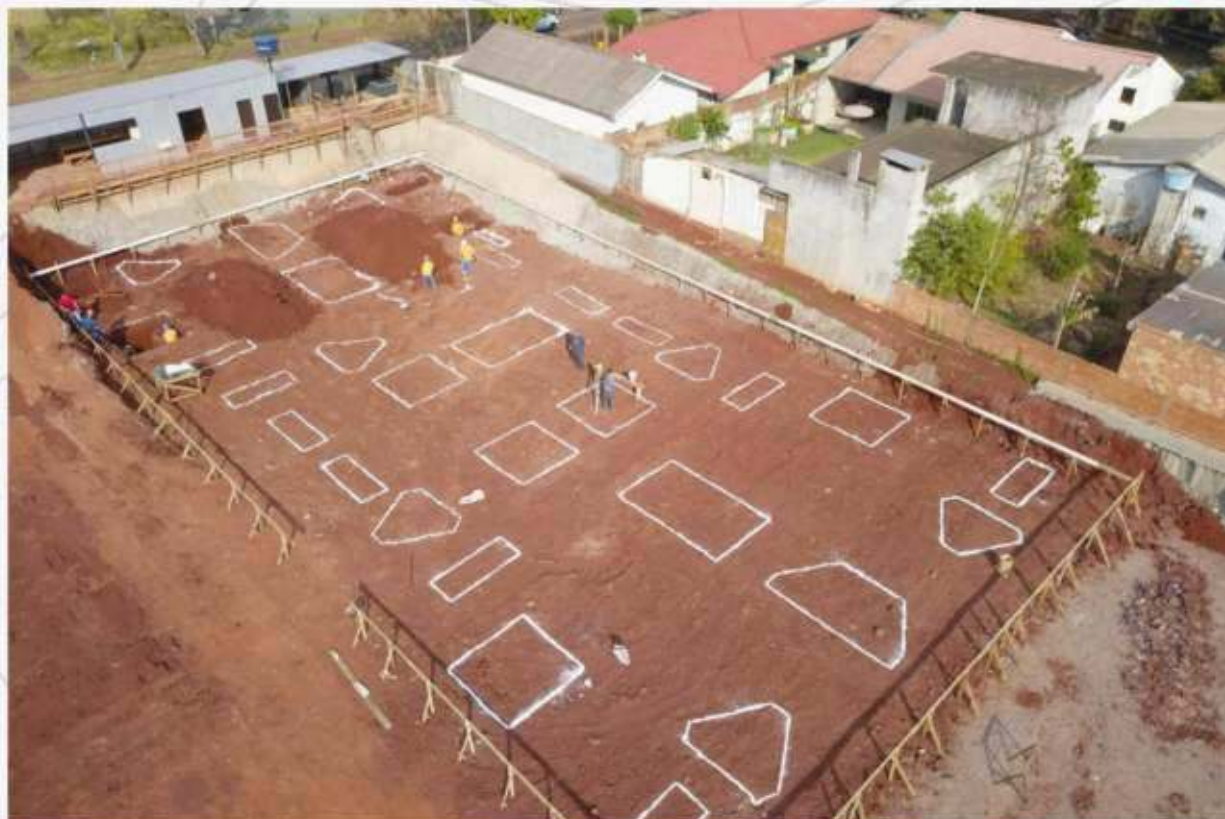
Demarcação de Bloco Estrutural para construção do Prédio Residencial We Coqueiral para empresa Schneider e Costa Construtora.
