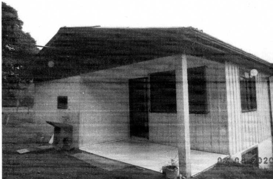
Foto 02 – Fachada Casa Rua João Scapinello (Nelci)
