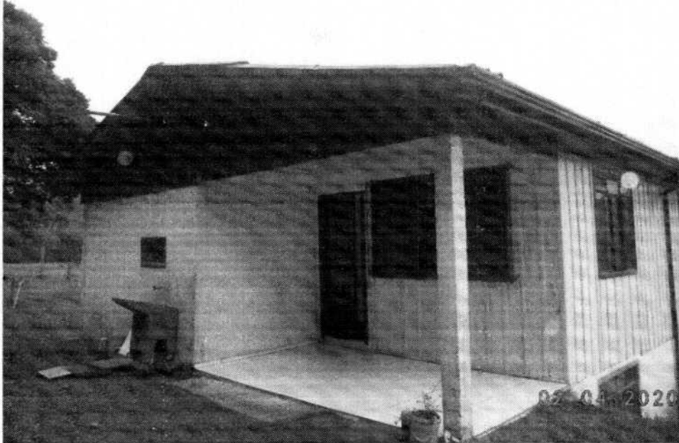
Foto 02 – Fachada Casa Rua João Scapinello (Nelci)
