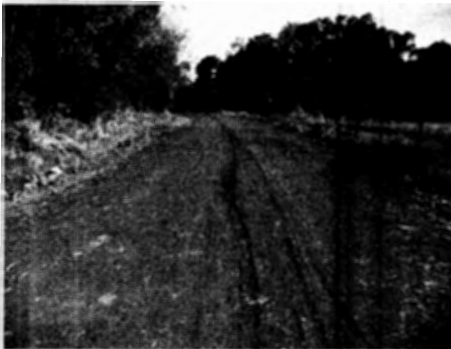
Foto 03 – Excesso de argila na pista.
