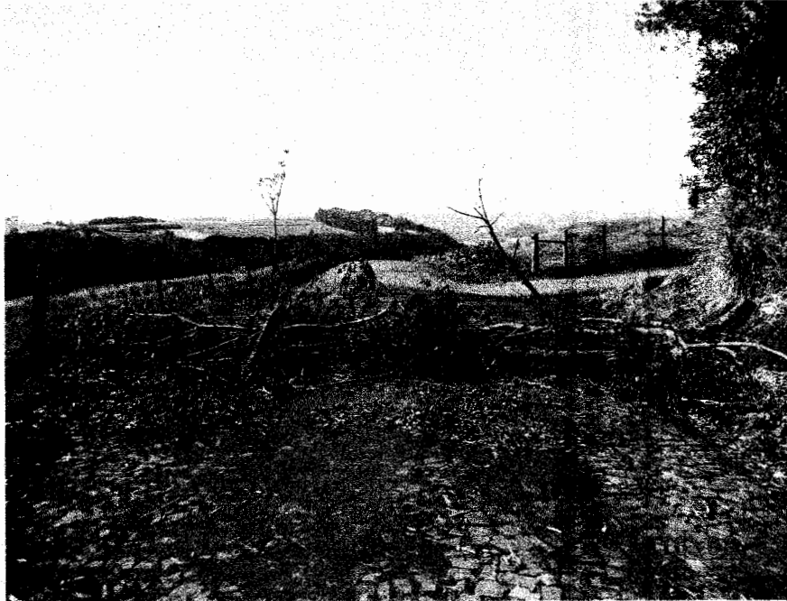
Foto 03: Trecho interrompido para tráfego.
